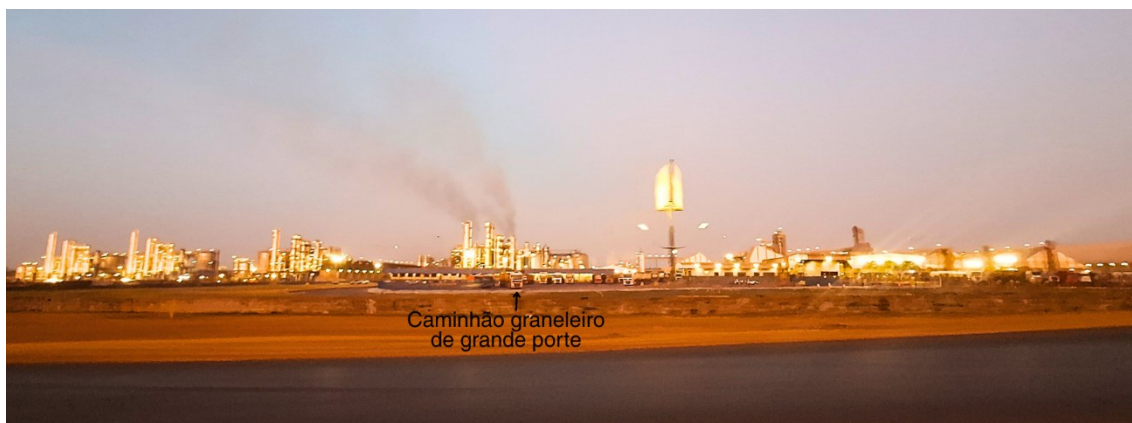
Foto 01: Planta da Inpasa vista da BR 163 em Sinop/MT. Fonte: o autor, 2025.
